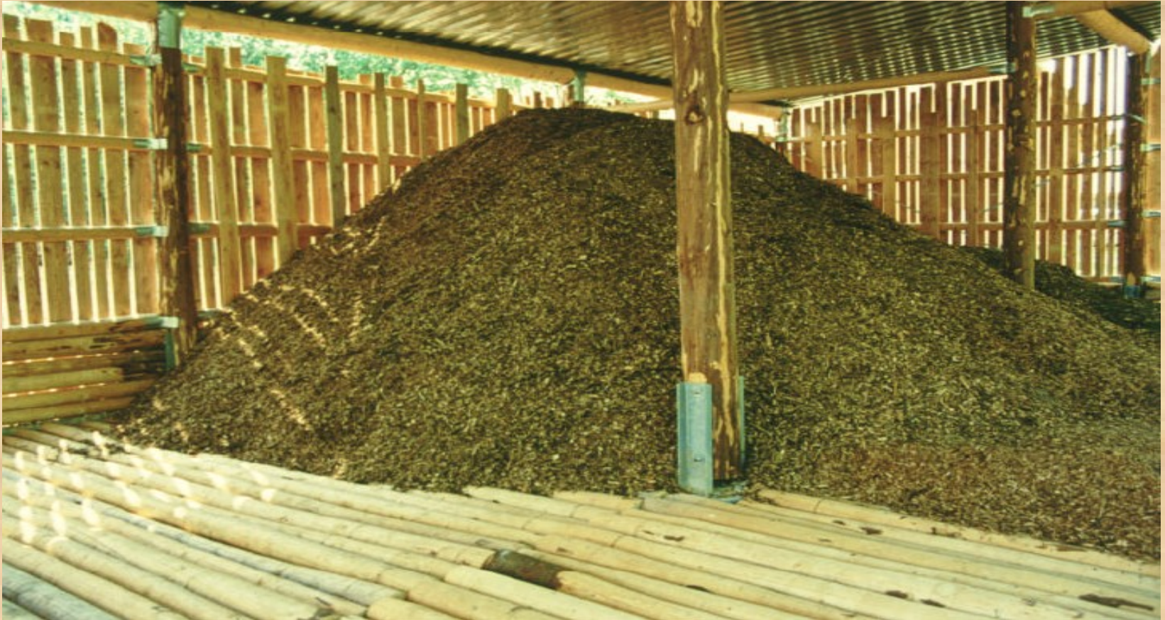
Beispiel einer einfachen und günstigen Lagerhalle
